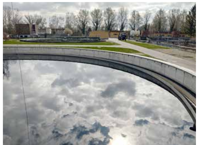
Nachklärbecken der Kläranlage Bruchniederung
