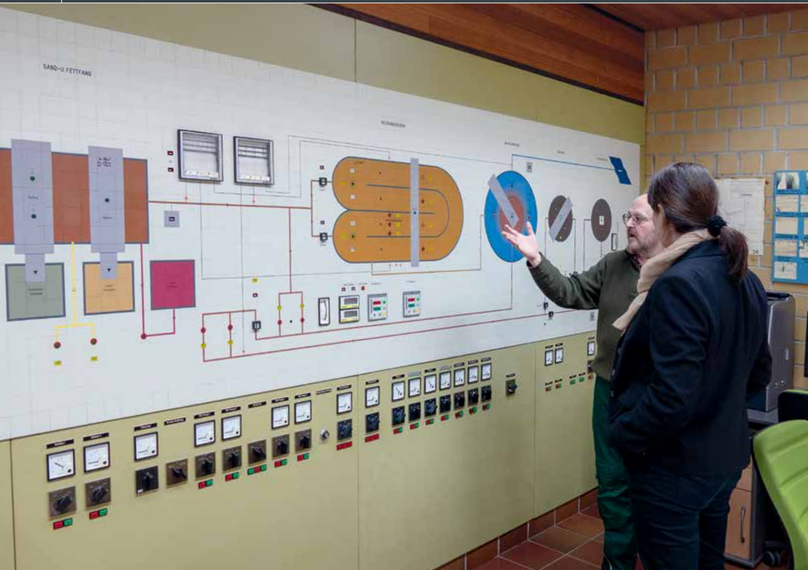
Abwassermeister Ehringer erklärt die Abläufe in der Anlage.
