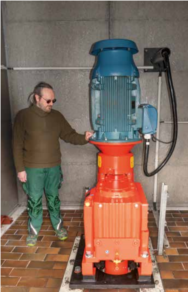
Größenvergleich: Abwassermeister Ehringer begutachtet das neue Getriebe.
