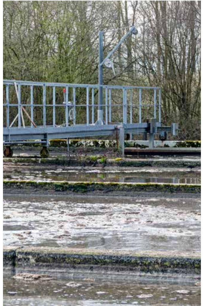
Belebungsbecken: Bewegung kommt ins Belebungsbecken mithilfe von Kreisel- und bei Bedarf auch von Wendelbelüftern.
