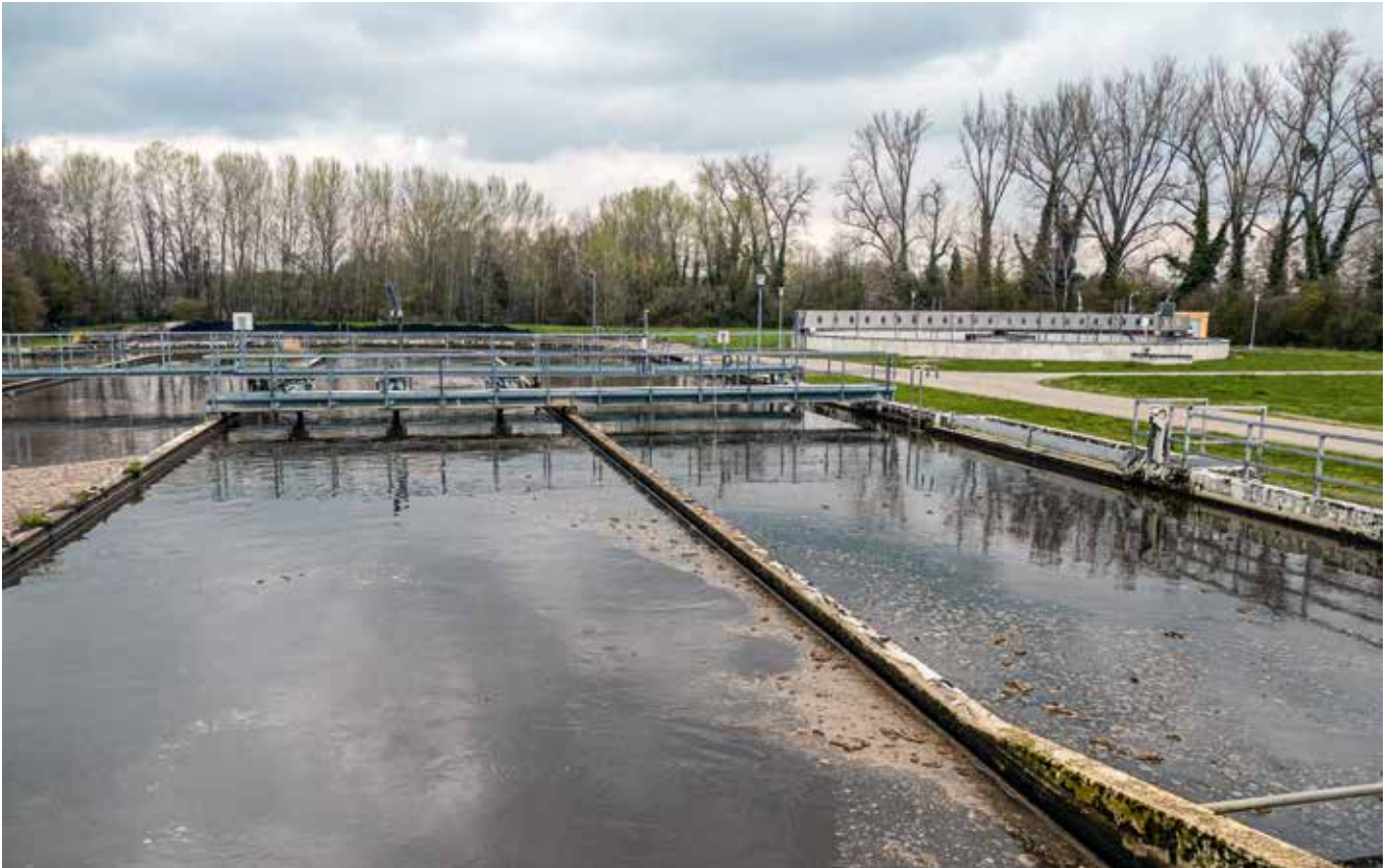
Belebungsbecken der Kläranlage Bruchniederung
