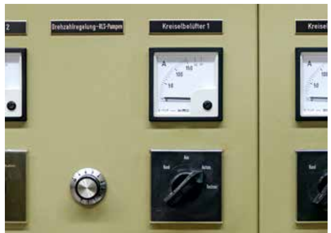
Antrieb 1 steht! Jetzt ist schnelle Hilfe erforderlich
