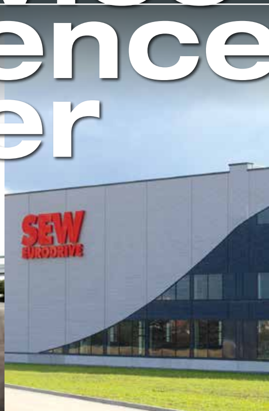
SCC Industriegetriebe Bruchsal
